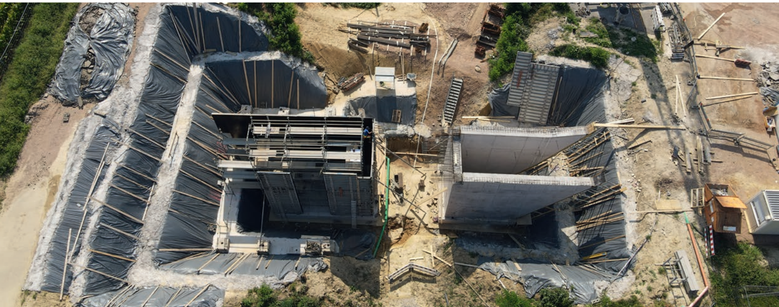
Neubau der Silberwaldbrücke in Gutach
